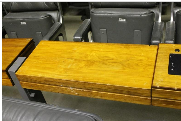
Bancada que teve o tampo superior danificado (após limpeza)
