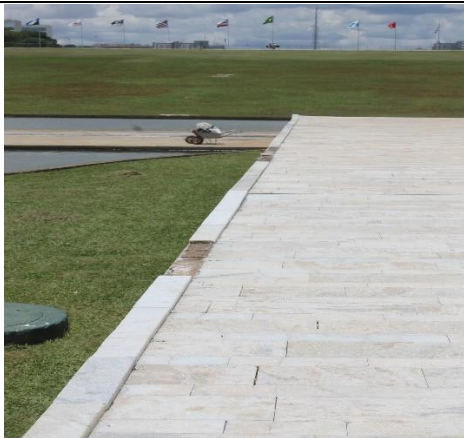
Rodapé da rampa do Congresso removidos da rampa
