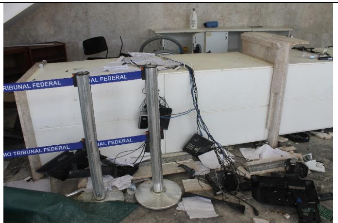
Bancadas em mármore quebradas
