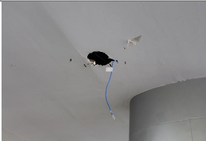
Depredação ao circuito fechado de televisão, com danos ao forro de gesso
