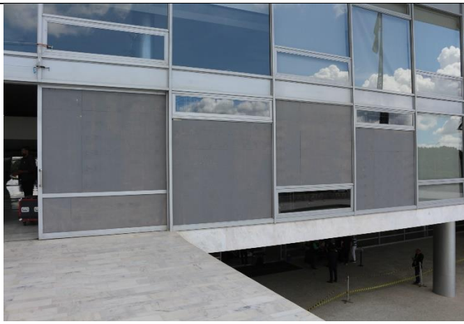
Vedações de esquadrias em madeira, provisoriamente instaladas
