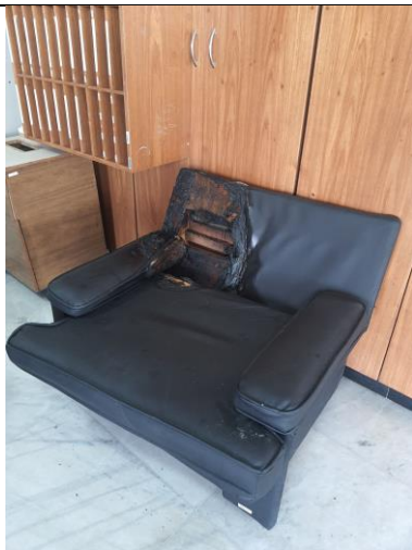
Poltrona danificada por fogo, localizada na sala do GSI, no primeiro pavimento.
