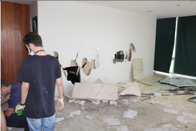
Parede parcialmente demolida
