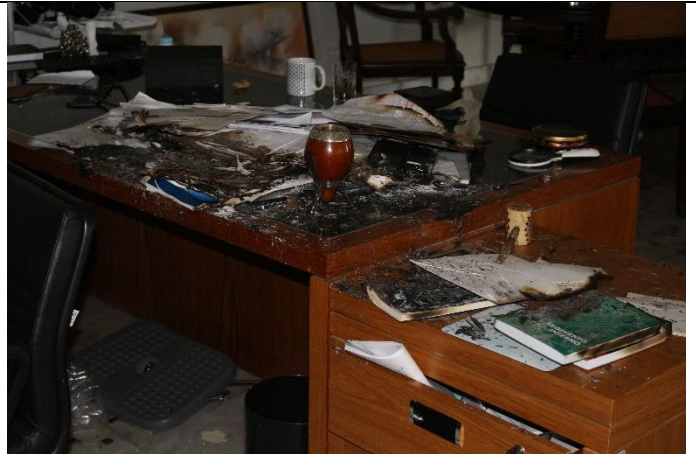
Princípio de incêndio em mobiliário
