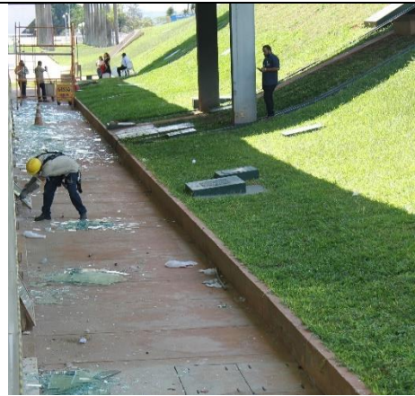
Vidros destruídos na fachada sul do Congresso Nacional
