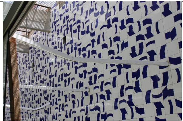
Danos à estrutura de suporte do painel Ventania
