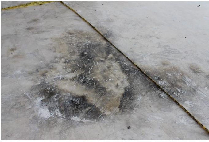
Piso de mármore manchado
