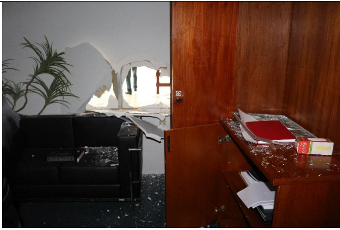
Parede parcialmente demolida
