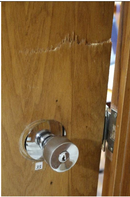
Porta com danos causados por arrombamento
